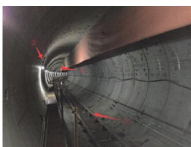
图 4 隧道及参考节点安装位置
